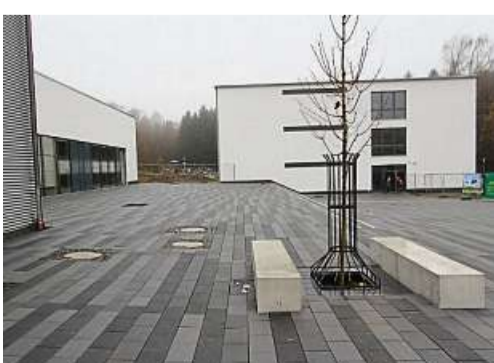
Die neue Aula (links) bietet eine sinnvolle Verbindung zum Bestandsbau. An der Stirnseite des Campus schließt sich das neue dreistöckige Unterrichtsgebäude an. Foto: a|sh
